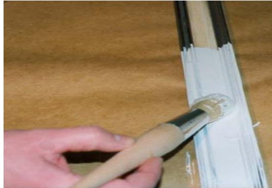
Zwischenschliff nach ca. 2-3 Aufträgen mit Schleifpapier Körnung 220 oder 240 ist empfehlenswert, ebenso wie Endschliff mit Schleifpapier in Körnung ca. 320.
